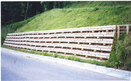
木製ブロック積工（新治村）
