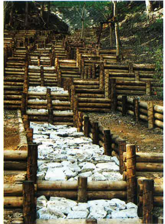
生活環境保全林整備事業（岩瀬町）
