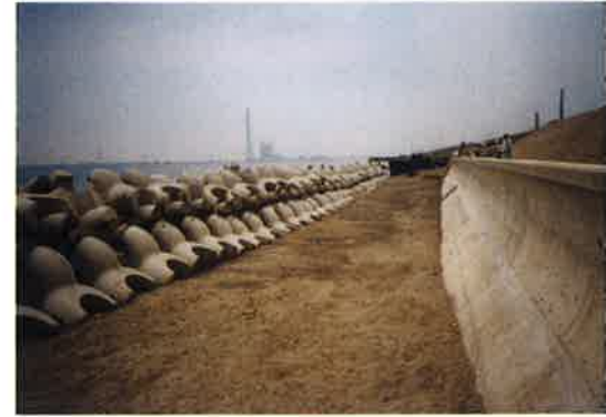
写真-2 復旧状況
