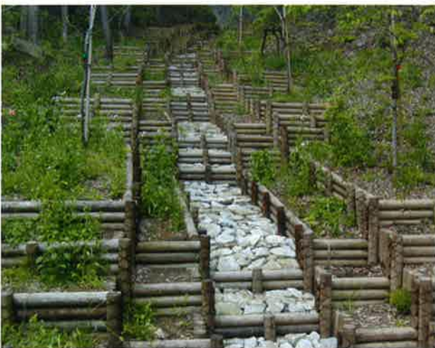
丸棒を使った水路工
