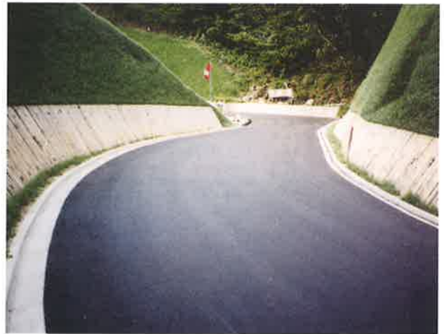
間伐材を使用した法面パネル工
