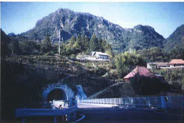
古分屋敷橋と男体トンネル
