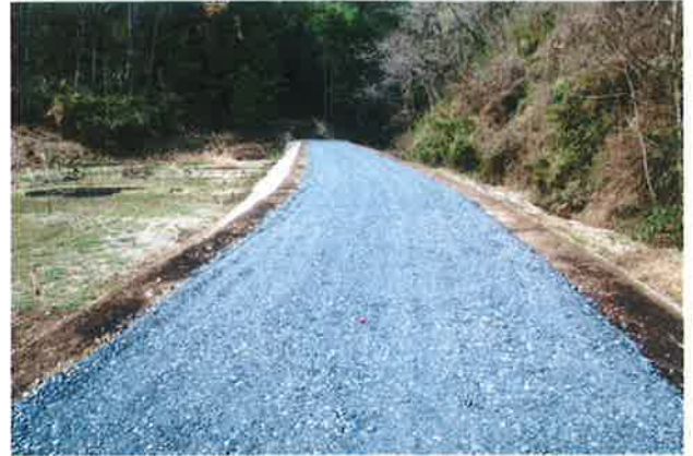
林道「膳部沢線」開設工事
