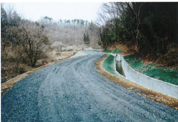
林道「岩の沢線」開設工事
