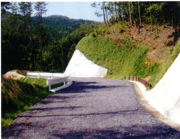
林道「鳥曾根線」開設工事
