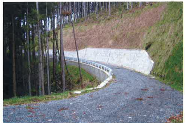
林道「本戸前山線」開設工事
