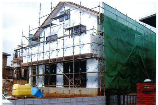
県産材を使用した木造住宅
