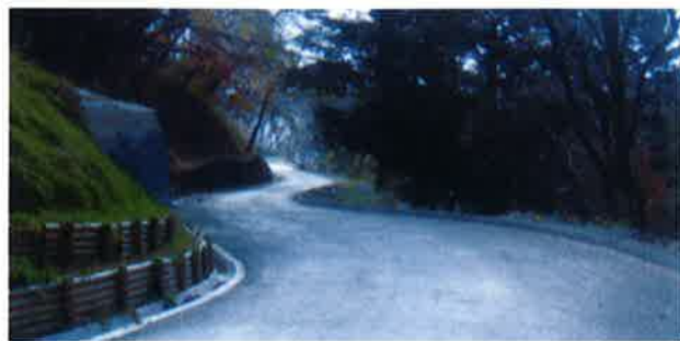
林道改良工事が進む「沼田新田酒寄線」
