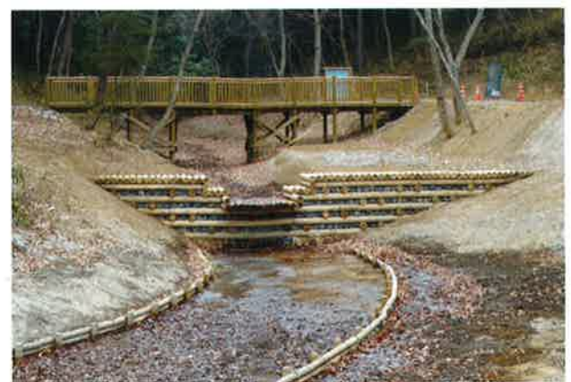
木製構造物（治山ダム工・流路工）
