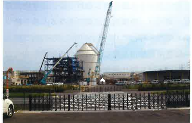
建設中のバイオマス発電施設
