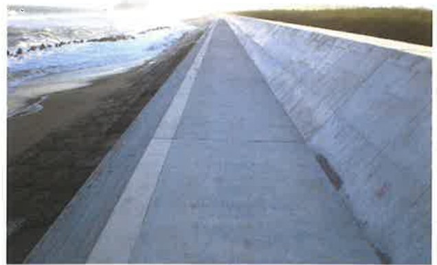
竣工状況(日立市十王町伊師地区)
