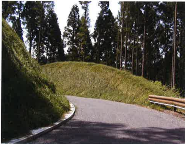
林道工事「奥久慈グリーンライン林道第1号北吉沢下野宮線」
