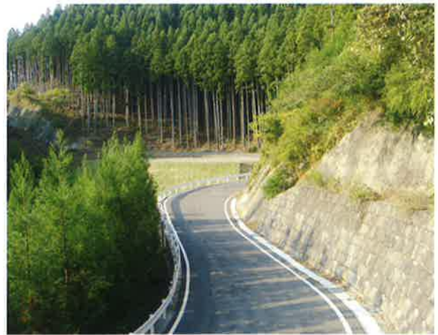
北吉沢下野宮線と間伐実施状況
