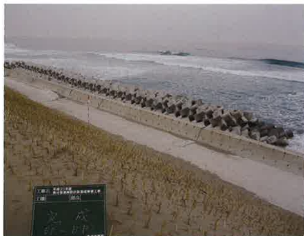
第4号海岸防災林造成事業
