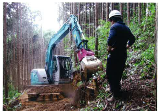
作業道開設研修
