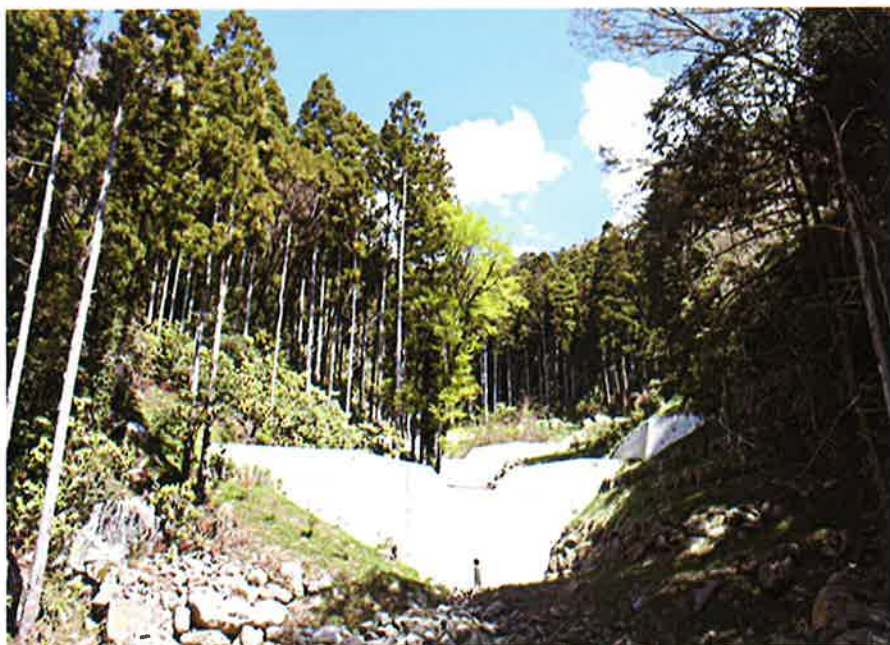
竣工した谷止工(平成18年～20年度施行)
