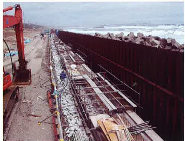
写真2 防潮護岸復旧状況 (大洗町成田)
