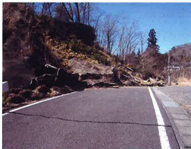
写真3 林道袋田・男体・湯沢線の被災状況 (大子町西金)
