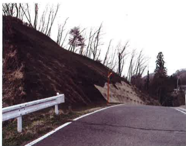
写真4 林道袋田・男体・湯沢線の復旧状況 (大子町西金)
