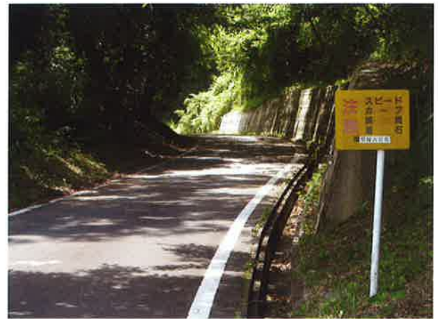
林道維持管理「岩の沢線」 常陸大宮市
