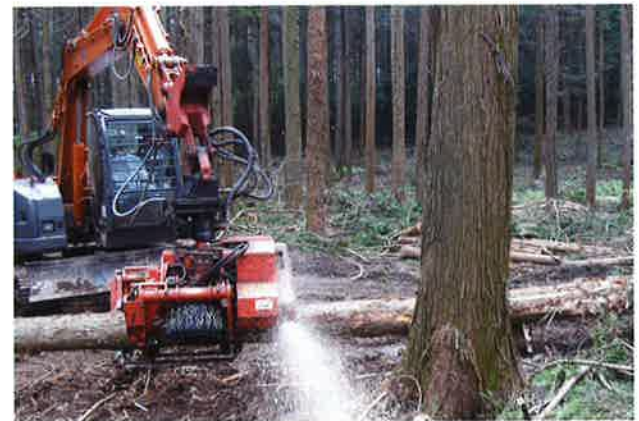
高性能林業機械による造材 (プロセッサ)
