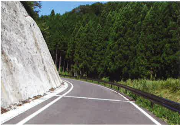
林道工事「奥久慈グリーンライン林道 第2号 武生線改築」 (株)鈴木組
