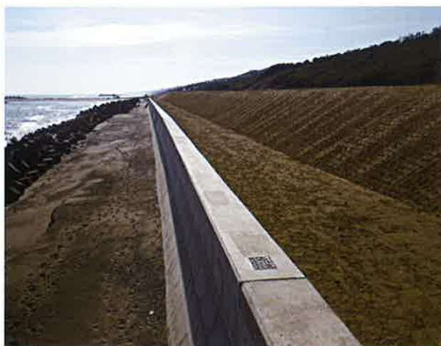
復旧状況 防潮護岸の復旧(大洗町成田地内)
