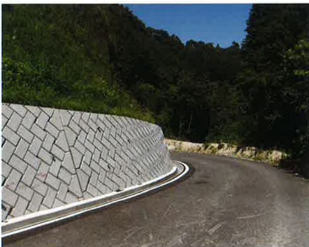
法面が復旧された「鳥曾根線」
