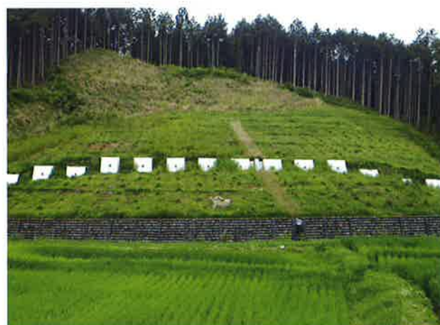
治山工事「第3-1号 災害関連緊急治山事業」 益子建設(株)
