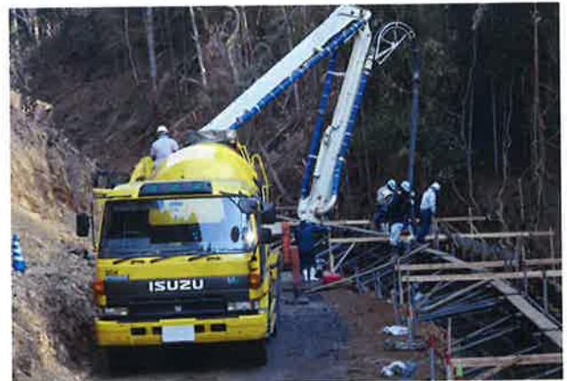
工事の様子(林道 膳部沢線)
