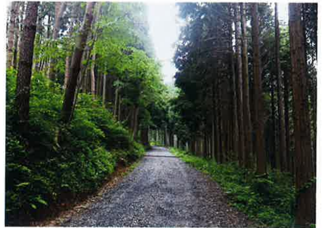
写真-1 林業専用道小里郷線の整備状況
