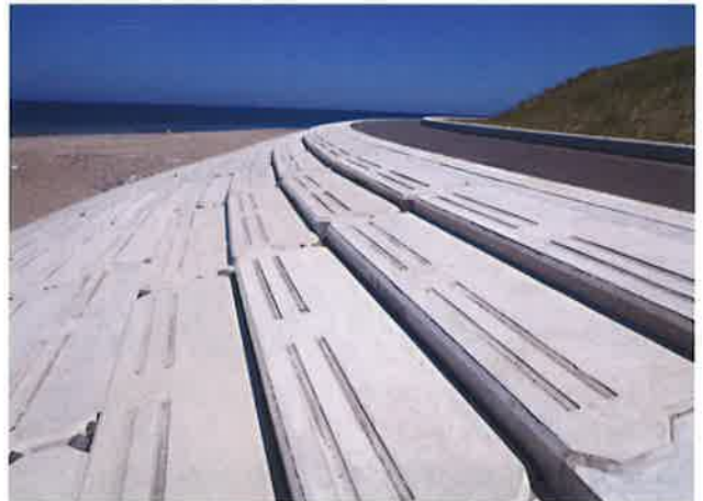
治山工事「第9号 海岸防災林造成事業」 (株)波崎建設
