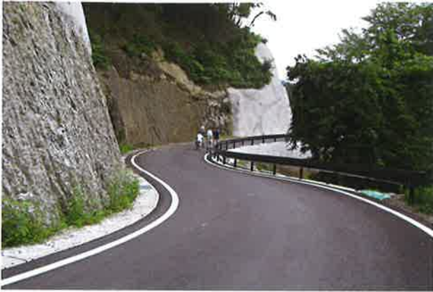
林道工事「第3号 奥久慈グリーンライン林道整備事業 武生線改築」(株)水府工務店
