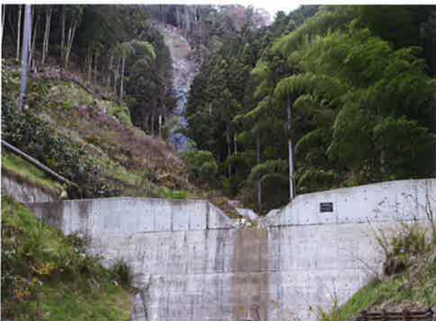
復旧状況(全景)
