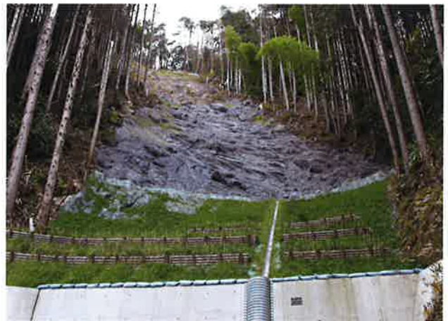
土留工復旧状況(山腹崩落箇所)
