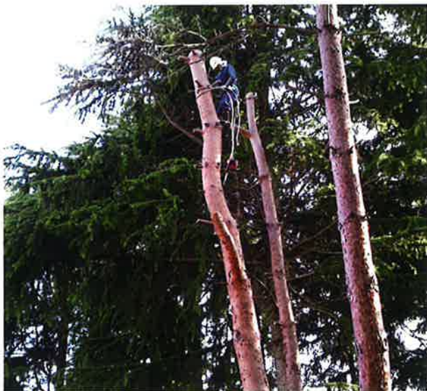
特殊伐採（吊るし切り）
