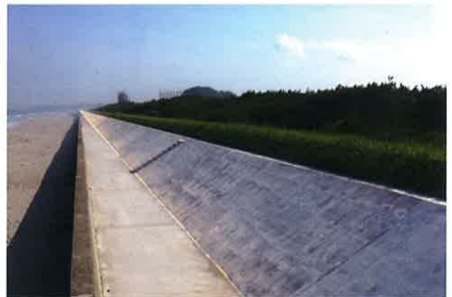
津波防災対策緊急整備事業 (北茨城市中郷町足洗)
