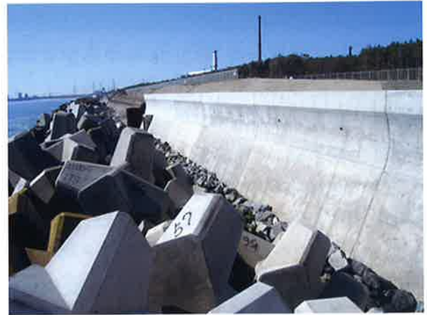
治山工事「津波防災対策緊急整備事業」 (株)岡部工務店
