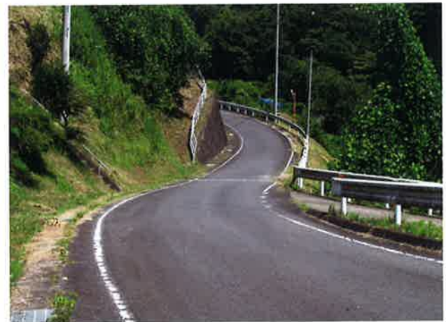
林道維持管理 「照山線」 常陸大宮市
