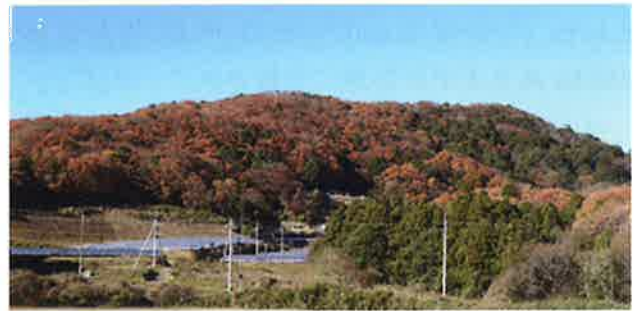
施工地の全景
