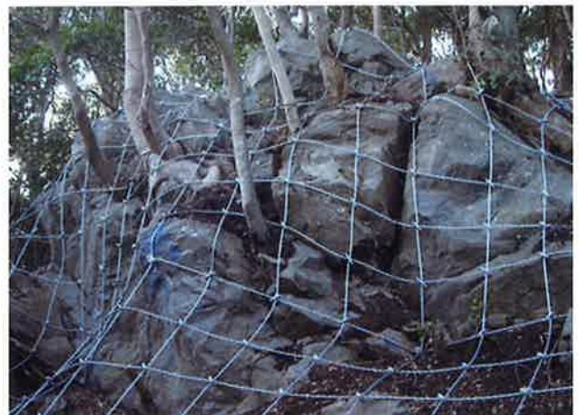
固定工設置状況
