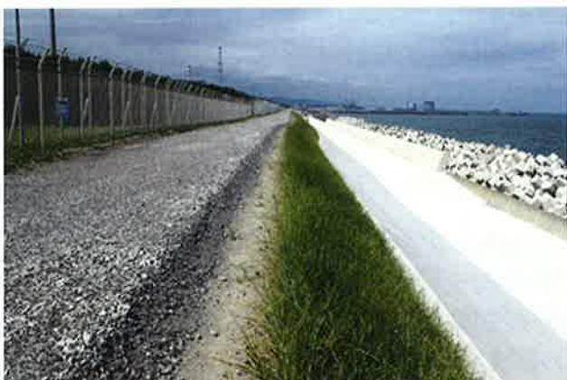
治山工事「津波防災対策緊急整備事業」 (株)岡部工務店
