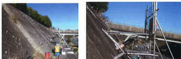
リフトオフ試験の様子
