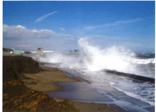
越波状況(事業着手前)
