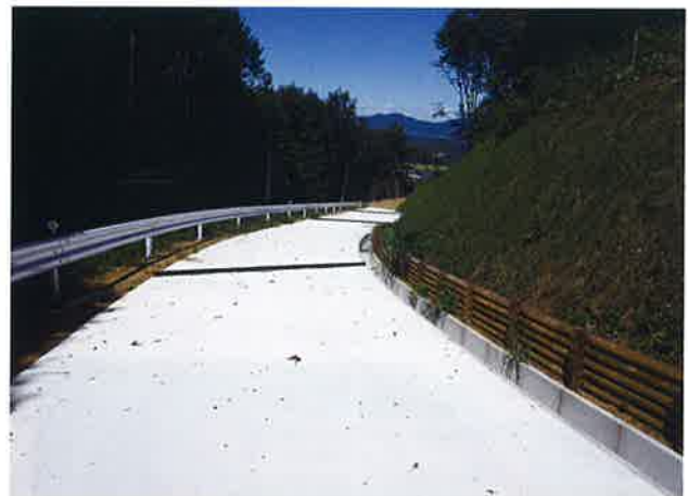
林道工事 小幡・中山線国補林道開設事業 (株)川又造園土木
