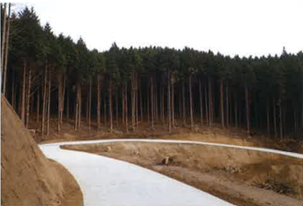
林業専用道の新設(日立市内)
