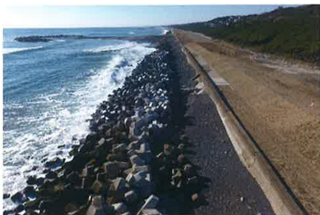
治山工事「海岸防災林造成」 (株)田口工務店
