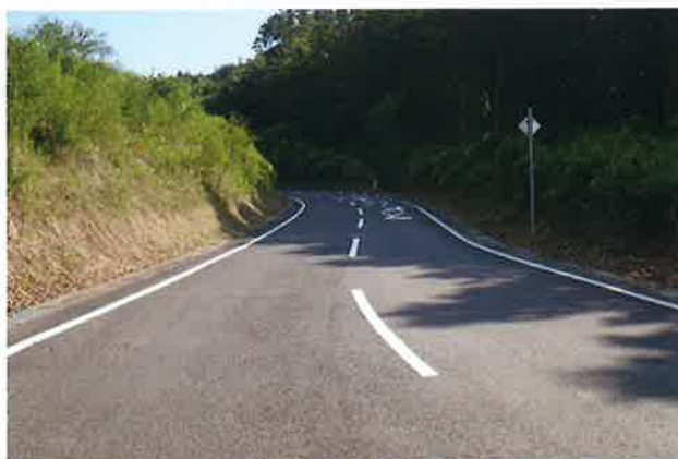
林道維持管理「水根持方線」 大子町
