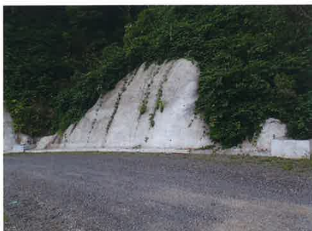
林道工事「武生線」 (株)水府工務店
