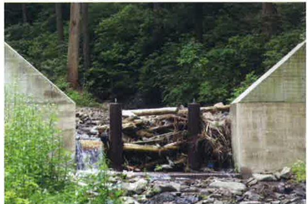
写真2 治山ダムによる流木の捕捉状況 (大子町頃藤地内)
