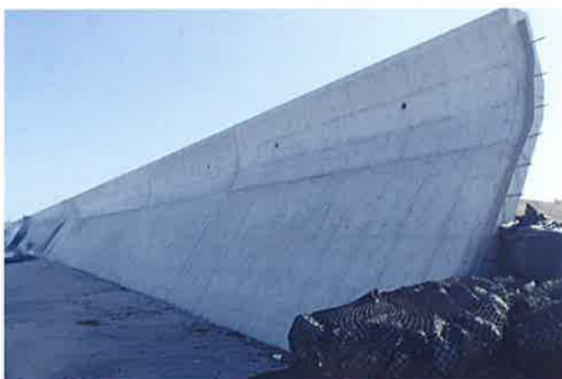
治山工事「海岸防災林造成」 (株)秋山工務店
