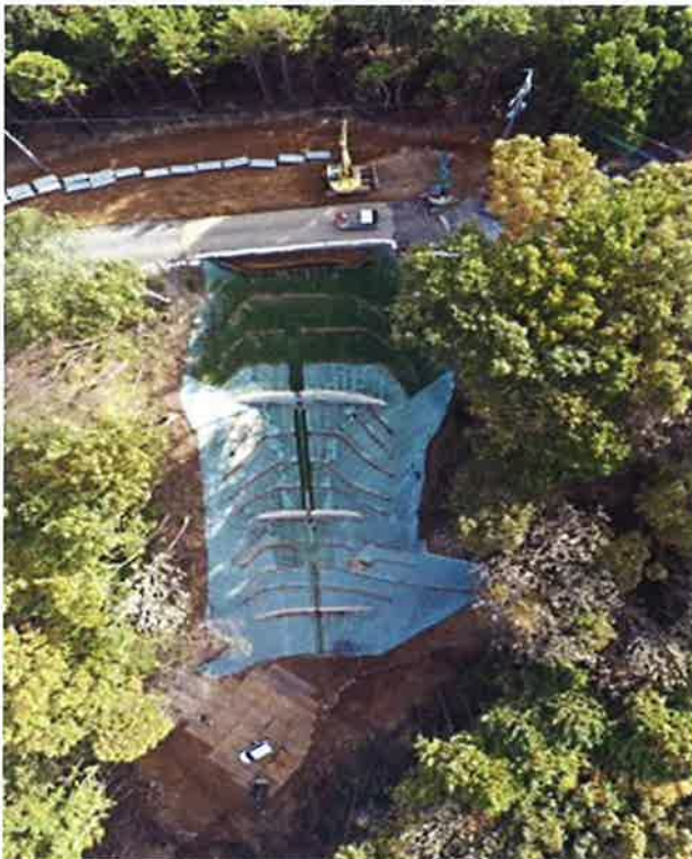
写真1 笠間市上加賀田における 災害関連緊急治山事業
