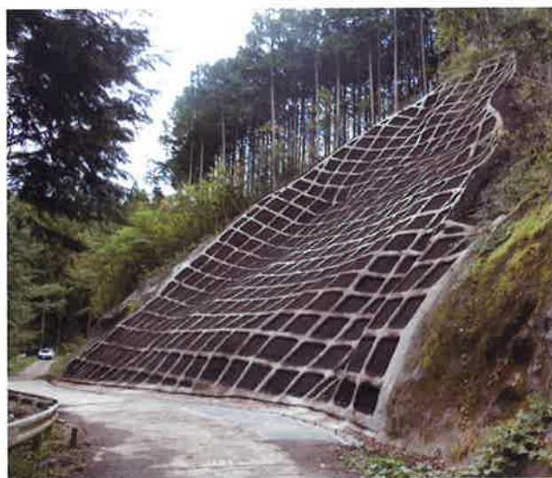
簡易法枠工法による復旧 (林道：道口ク神線)
