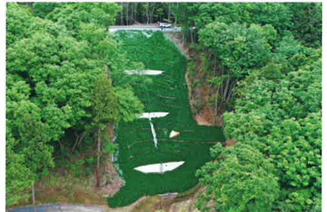
崩壊地の復旧後の様子
