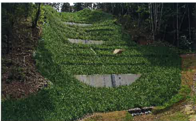
治山工事「災害関連緊急治山」(株)高田工務店
