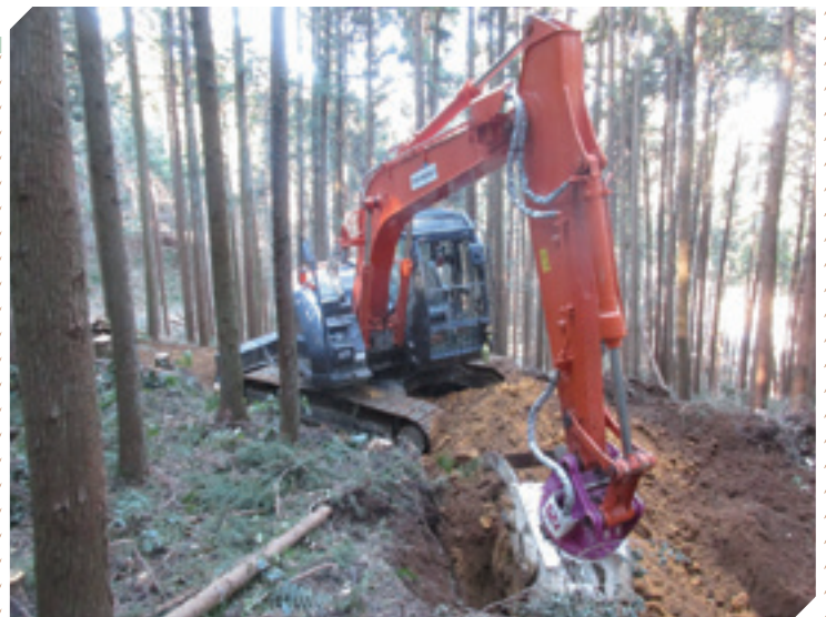
作業道開設状況
