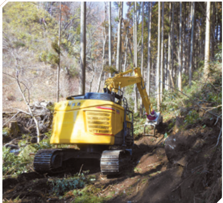
作業道開設状況
