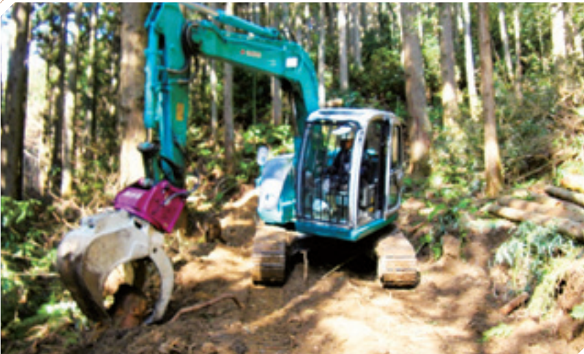
間伐作業道の開設
