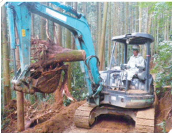
作業道の作設
