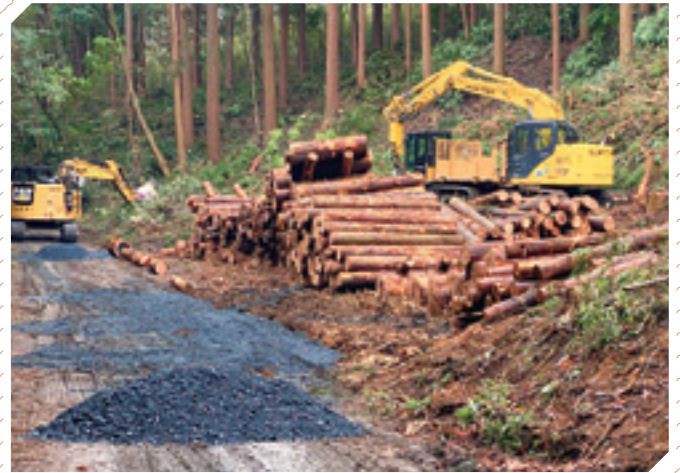
土場前の林道整備
