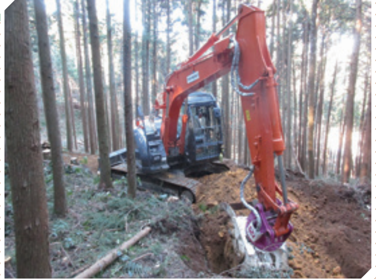
作業道開設状況
