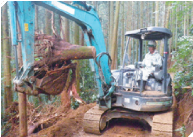
作業道の作設
