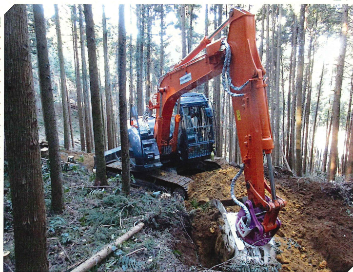
作業道開設状況
