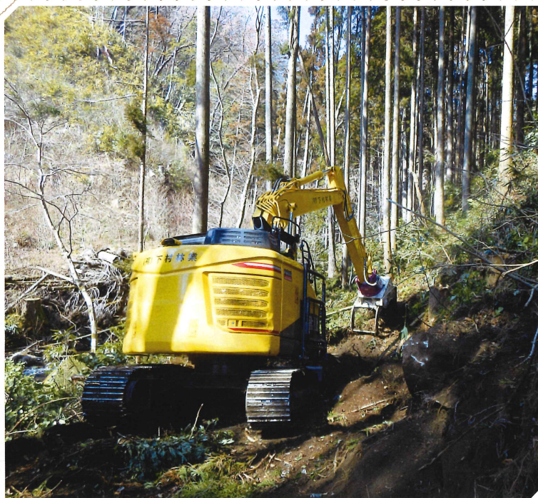
作業道開設状況
