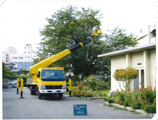
高所作業車による伐採作業
