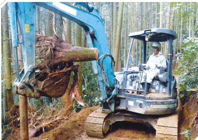
作業道の作設
