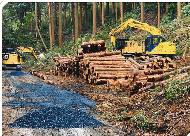
土場前の林道整備
