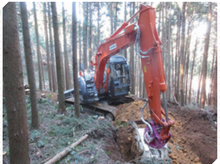
作業道開設状況
