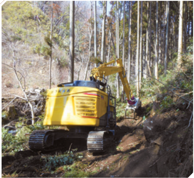
作業道開設状況
