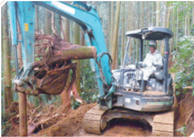
作業道の作設
