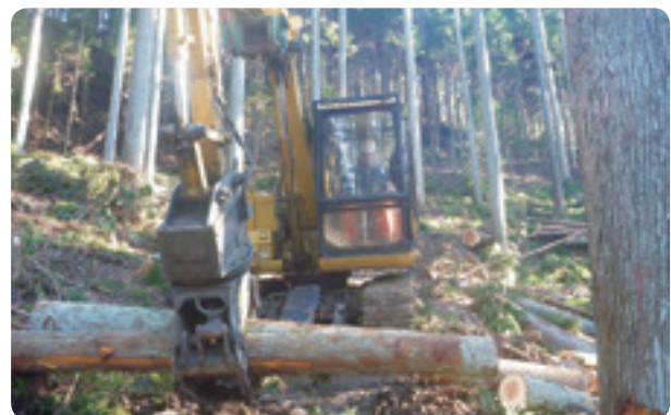
グラップルによる集材作業
