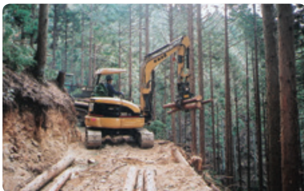
グラップルによる集材作業
