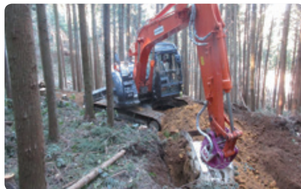
作業道開設状況
